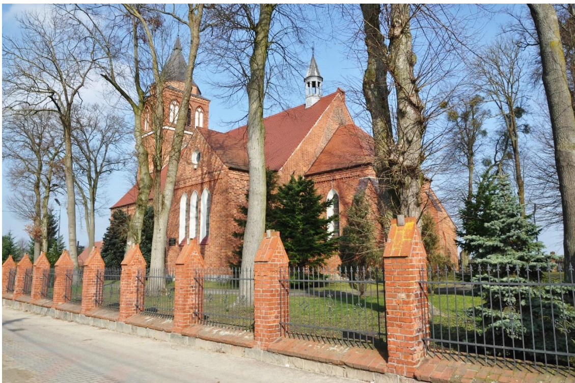
Fot. 4. Widok na kościół od strony południowo-wschodniej.
