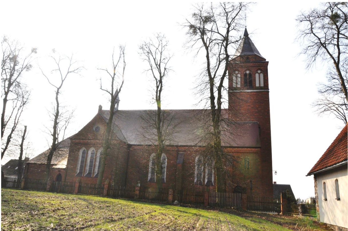
Fot. 6. Elewacja północna.
