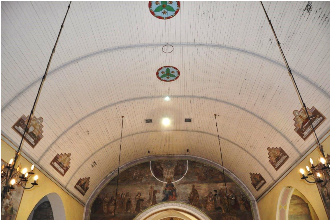
Fot. 13. Sklepienie nad nawą.
